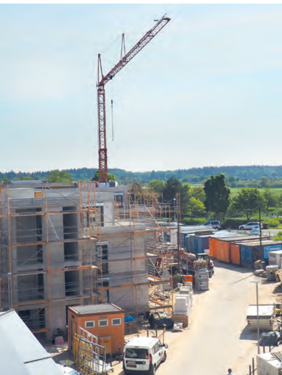
Arbeiten am letzten Bauabschnitt vom jüngsten Neubauprojekt in Eggenstein, Sonnenallee
