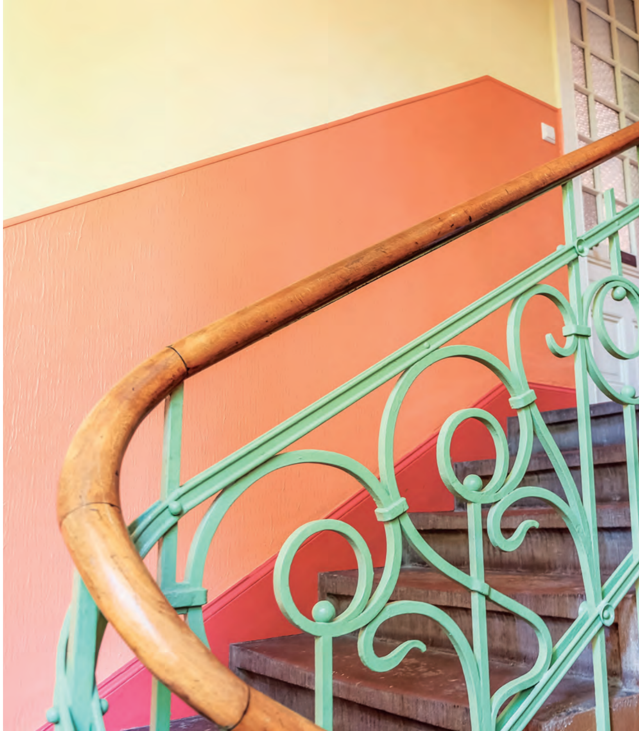
Denkmalgerechte Sanierung eines Altbau-Treppenhauses
