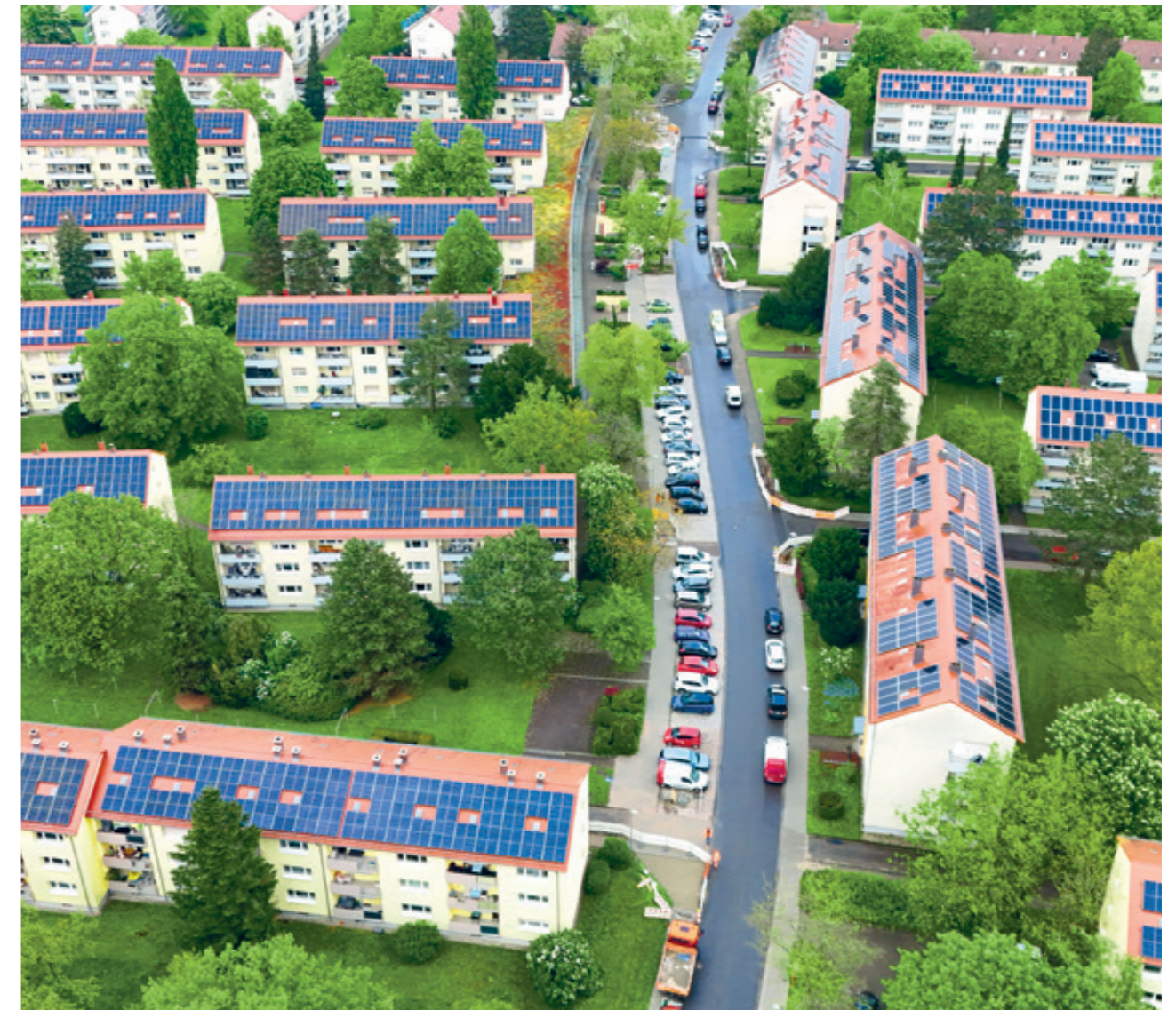
Neu installierte PV-Anlagen auf den Dächern in der Rheinstrandsiedlung
