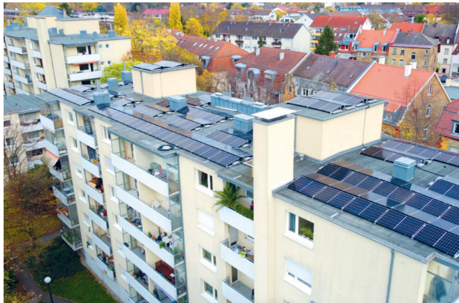
PV-Anlagen auf den Dächern der Veilchenstraße
